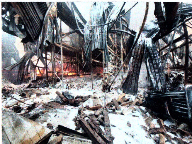
Imaginea nr. 7. Gradul de afectare termică a mărfurilor industriale și elementelor constructive din partea stângă a depozitului.
