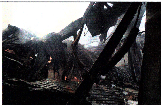
Imaginea nr. 11. Gradul de deformare a elementelor de construcție din metal din partea dreaptă a depozitului.
