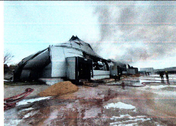
Imaginea nr. 4. Gradul de afectare termică al depozitului SRL „XXXX” din partea stângă.
