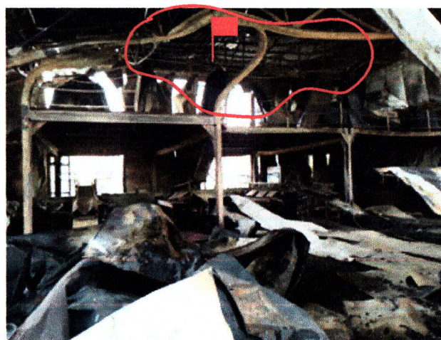
Figura nr. 7. Amprenta incendiului asupra elementelor din lemn. Modalitatea de determinare a gradului de carbonizare (adâncimea) a lemnului. Semnele focarului de incendiu.
