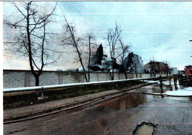
Imaginea nr. 5. Gradul de afectare termică al depozitului SRL „XXXX” din partea străzii.
