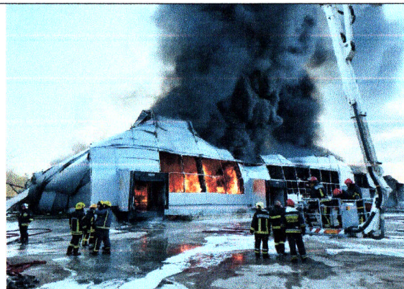
Imaginea nr. 2. Aspectul exterior al depozitului SRL „XXXX” supus incendiului.
