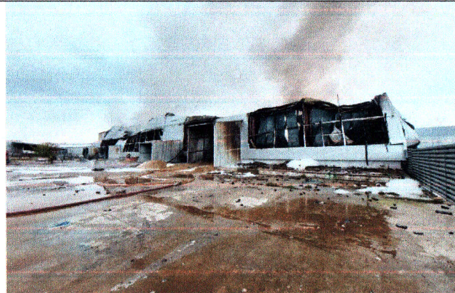
Imaginea nr. 3. Gradul de afectare termică al depozitului SRL „XXXX” din partea dreaptă.
